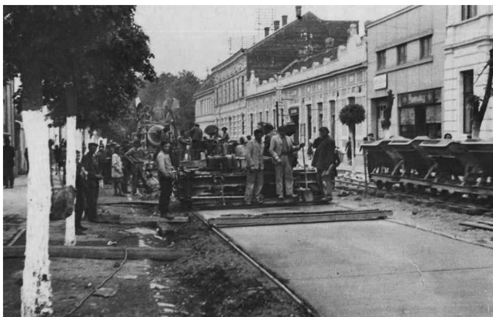
Бетонирање Железничке улице; негујо њошћо су ови радови завршени, ируја је демонишћрана
